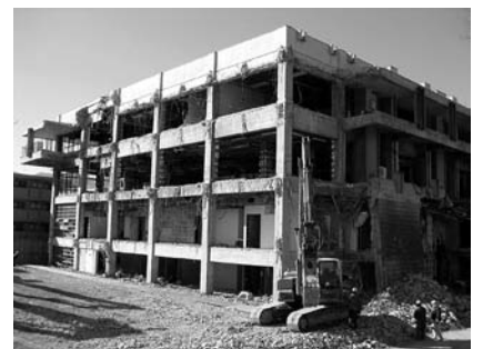
市民会館解体の様子 (1月初旬)
